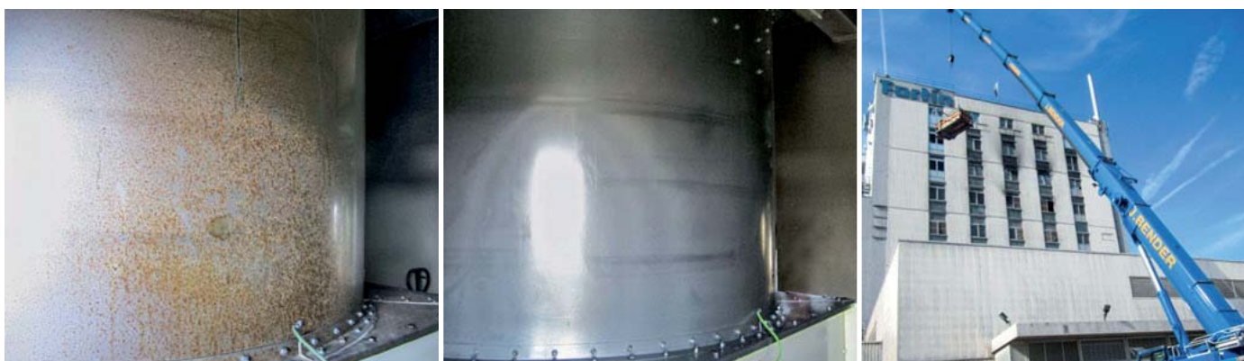
Edelstahlbehälter vor und nach der Sanierung.
