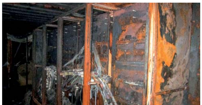
Der Schaltschrank zur Steuerung der Anlage brannte vollständig aus.
