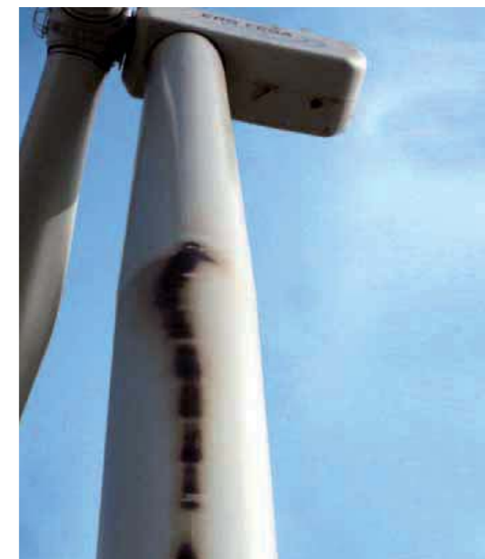
Sichtbare Brandschadensfolgen an der Turmaußenhaut
